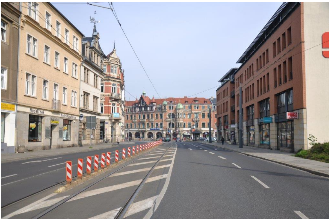
Einmündung der Tolkewitzer Straße in den Schillerplatz mit dauerhaften Trennelementen.
