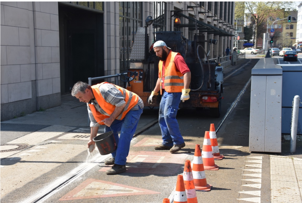
Verfüllung von Straßenbahnschienen in Düsseldorf.
