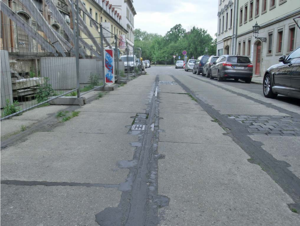
Verfüllte Straßenbahnschienen in Dresden (Heinrichstraße).
